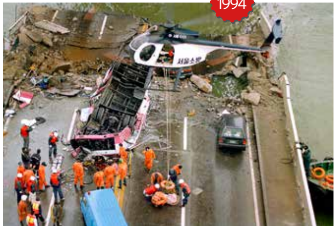
성수대교 불리 현장 구조작업
