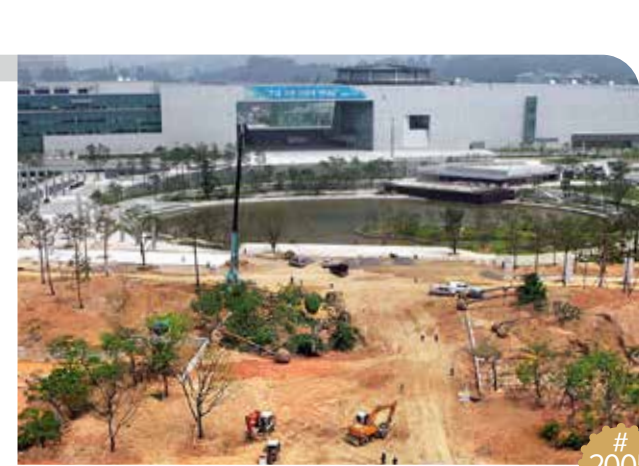
국립중앙박물관 조성 공사
