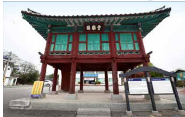
⑧ 옛 면천군의 문루인 풍락루. 1851년 당시 면천군수인 이관영이 새롭게 지어 '豊樂樓'(풍락루)라 명명했다.
